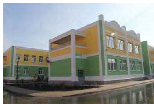
Фото № 5. Фасад ДООУ № 97.
