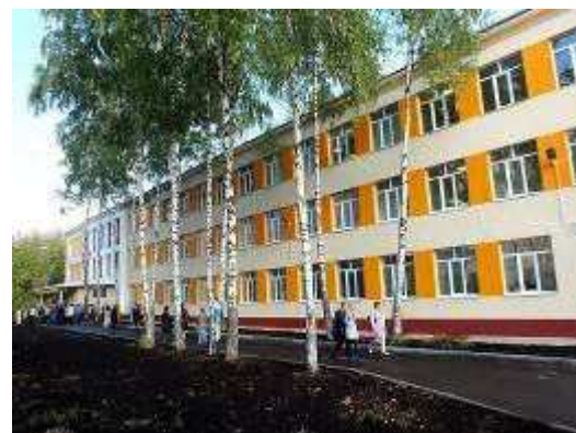
Фото № 6. Фасад 2 го корпуса школы № 14
